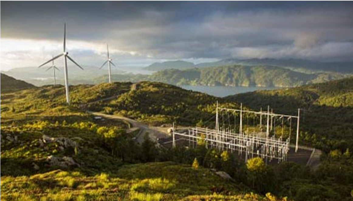
Figur 5.2 – Midtfjellet 1, 2 og 3 med transformatorstasjon
